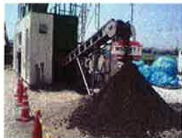
高含水土固化処理
