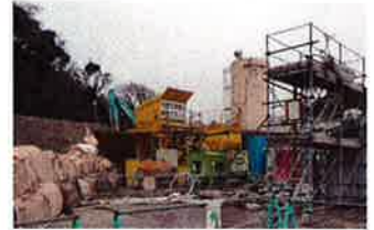
流動化処理プラント
