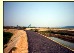
浚渫土 堤防(緑化)
