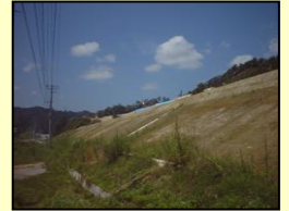
トンネルブリ 盛土
