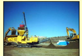
浚渫土の客土化タンク埋設 (緑化)
